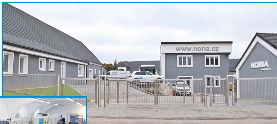
Výrobní areál společnosti NORIA v Tavíkovicích
